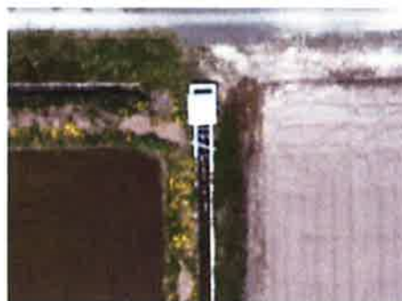
—既設用水路（開水路）起点部柵—
