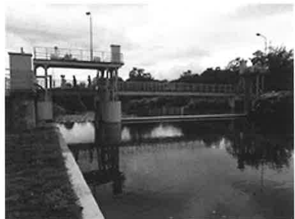
写真-1 頭首工改修状況
