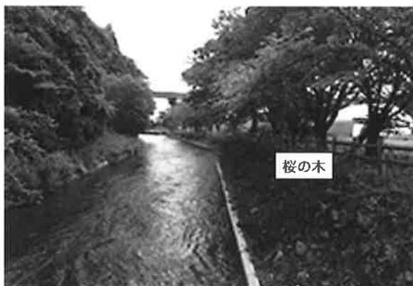
写真-3 河岸状況-1
