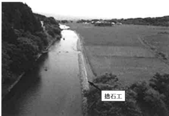
写真-4 河岸状況-2
