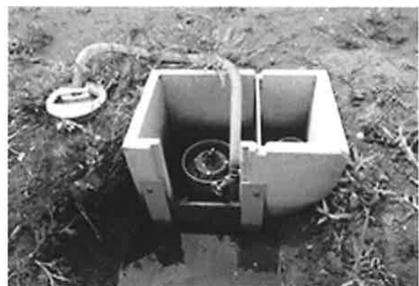
写真-5 フォアス樹(給水栓状況)
