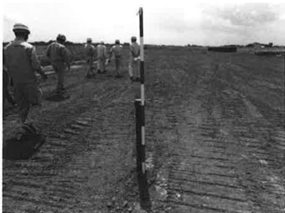
写真-3 逆川埋立後の状況(写真中央は設置した沈下板)
