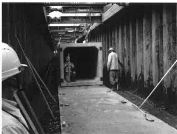
写真-6 施工敷高の確認作業
