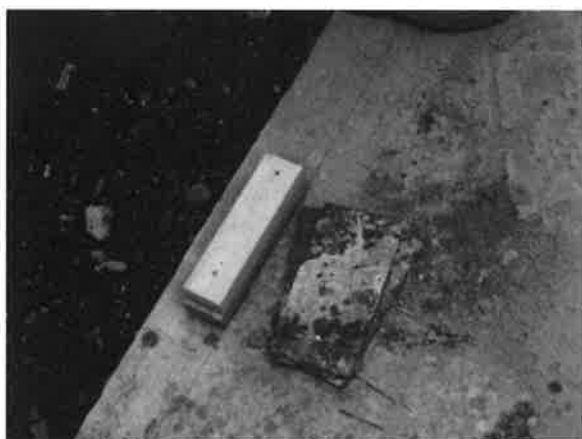
写真-5 施工敷高を調整するゴム板
