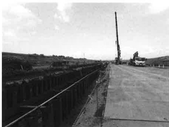
写真-4 導水路の施工状況
