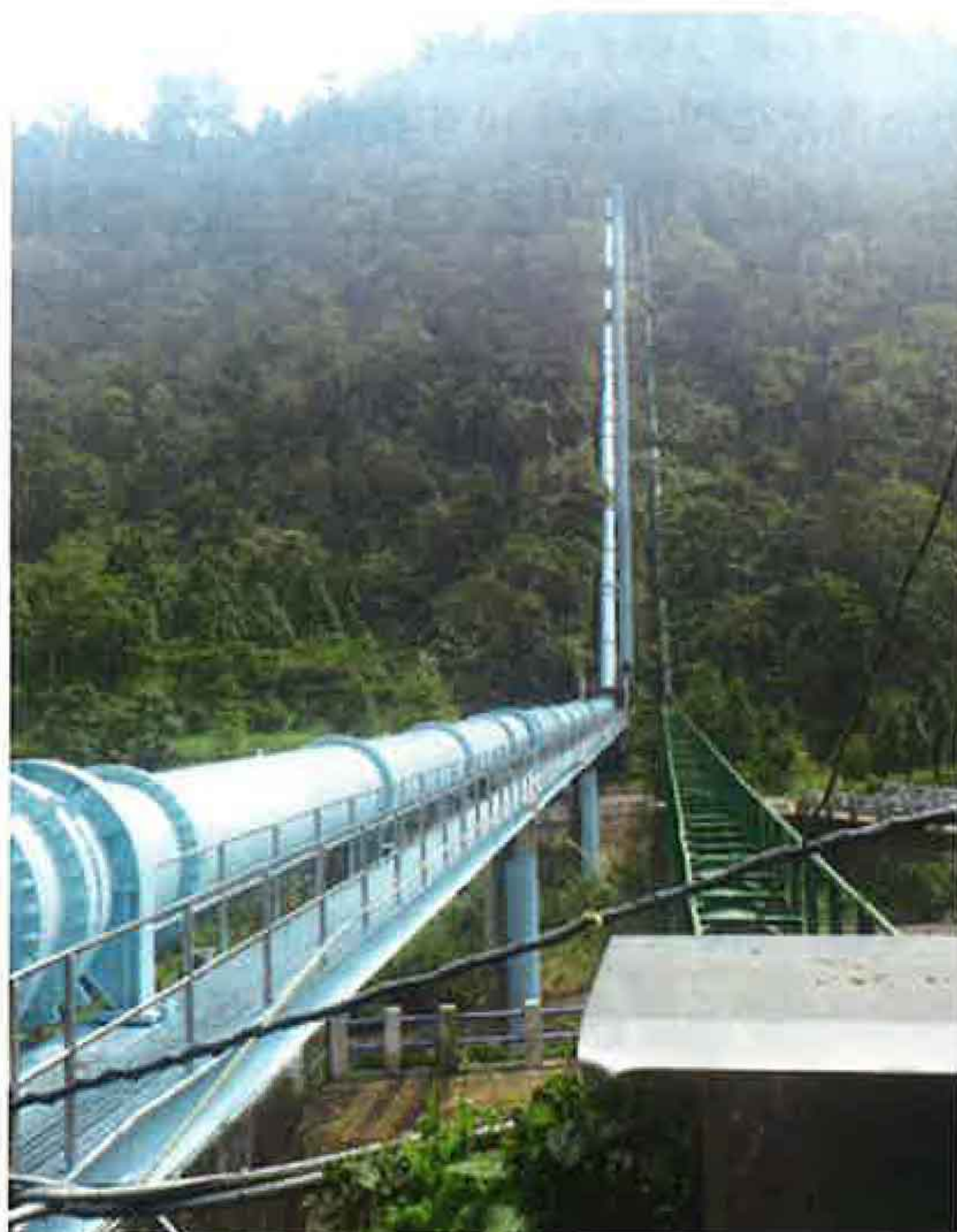
写真 3：第 2 号逆サイフォン工近景
