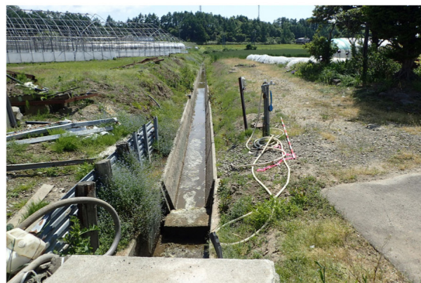
写真－９ 生活排水路（トラフ装工）
