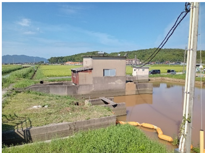
旧排水機場(=沖ノ島排水機場)
