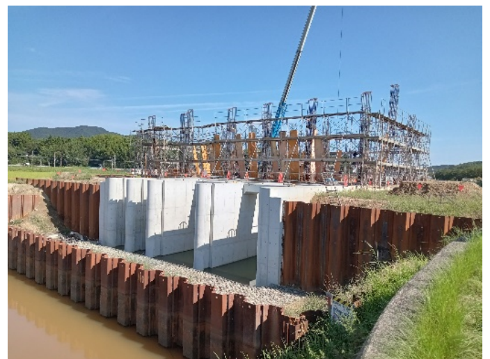
布崎排水機場 施工現場
