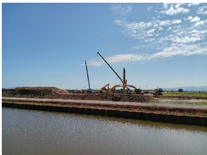
論田川排水機場杭基礎打設現場
