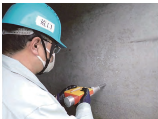
写真－８ シュミットハンマーによる強度試験
